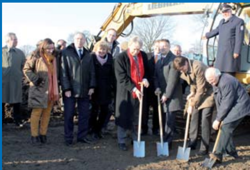
Spatenstich zur Erweiterung der Kreisfeuerwehrzentrale im WEP Gewerbegebiet.
