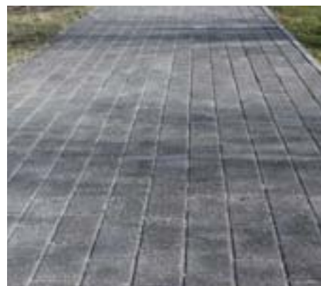
Am Ende der Maßnahme ist der Gehweg wieder in einem einwandfreien Zustand.
